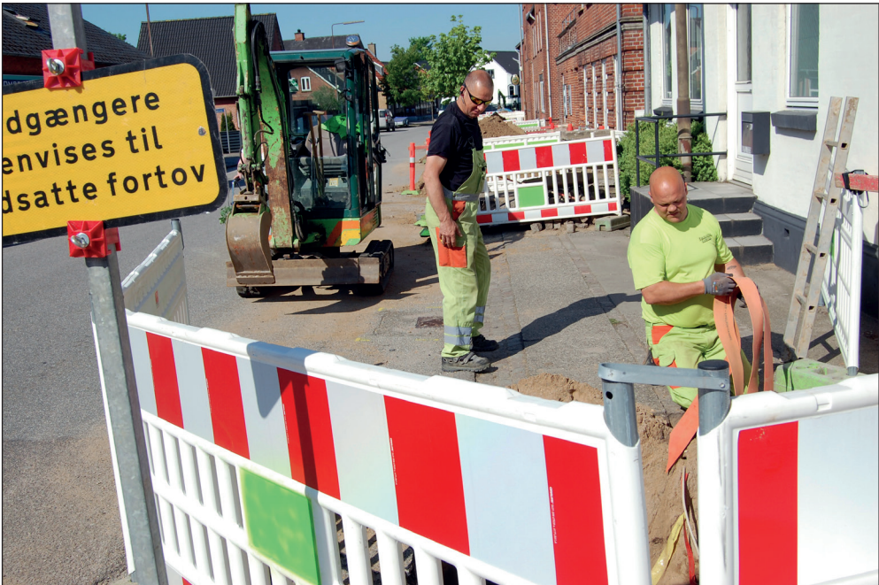
Arbejdet med at udskifte hovedledningen er i fuld gang. Her er det Gert Madsen og Heino Jensen, fra Hans Frisesdahl A/S, der har fattet gaveværktøjet. (Foto: SVEND ERIK MATTHIAS-BRODERSEN, NETAVISEN)
